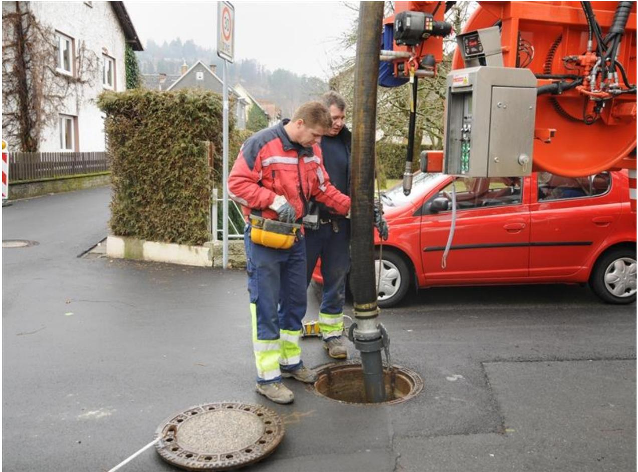
Fachkräfte für Rohr-, Kanal- und Industrieservice kontrollieren im Schwerpunkt Rohr- und Kanalservice z.B. die Abwasserkanäle von Privathäusern auf undichte Stellen oder Verunreinigungen. Dazu verwenden sie Spezialkameras und dichten mithilfe ferngesteuerter Roboter Schadstellen ab. Im öffentlichen Kanalnetz führen sie Routinekontrollen durch, prüfen Rohre, Becken und wasserführende
