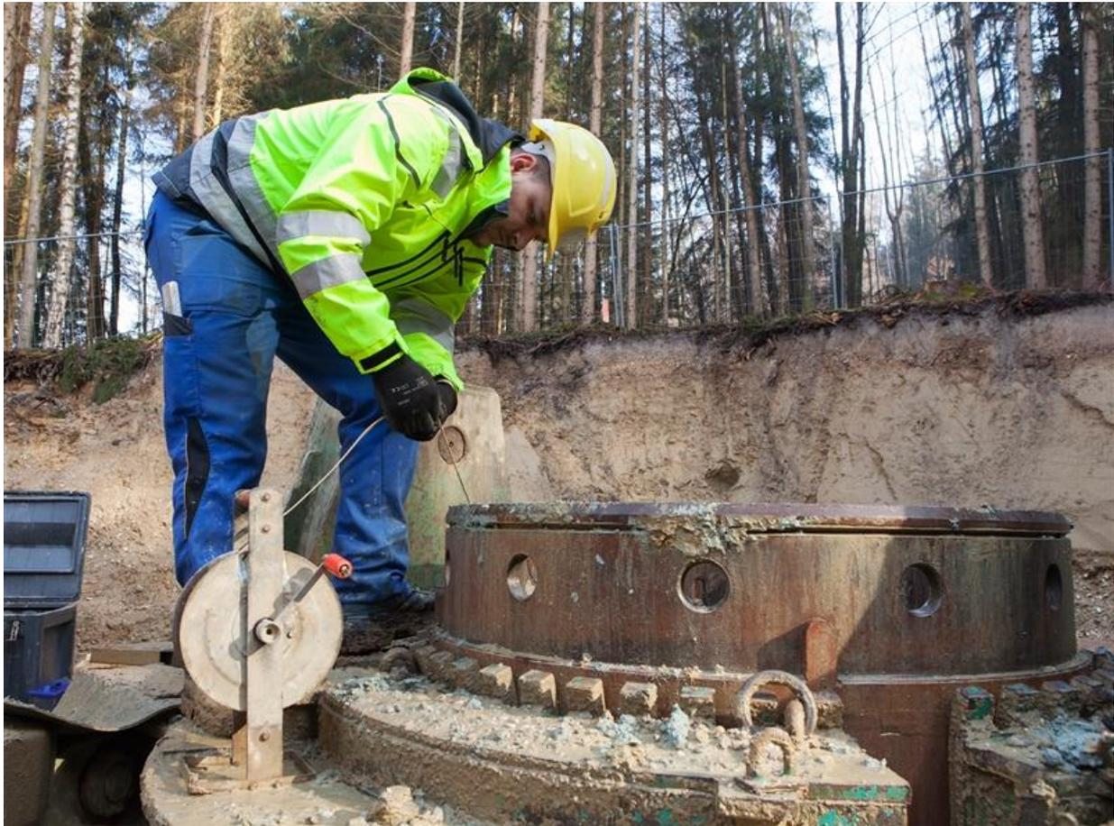
Brunnenbauer/innen führen Bohrungen durch, um unterirdische Wasservorräte zu erschließen und nutzbar zu machen. Durch Probebohrungen stellen sie fest, wo gutes Trinkwasser zu finden ist. Dann richten sie die Baustelle ein, bohren Brunnenschächte, verlegen Rohre und bauen Pumpwerke ein, um das Wasser nach oben zu befördern.
